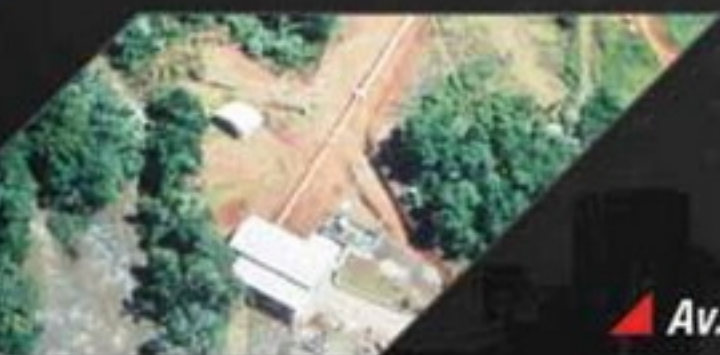
Pequenas centrais hidrelétricas
