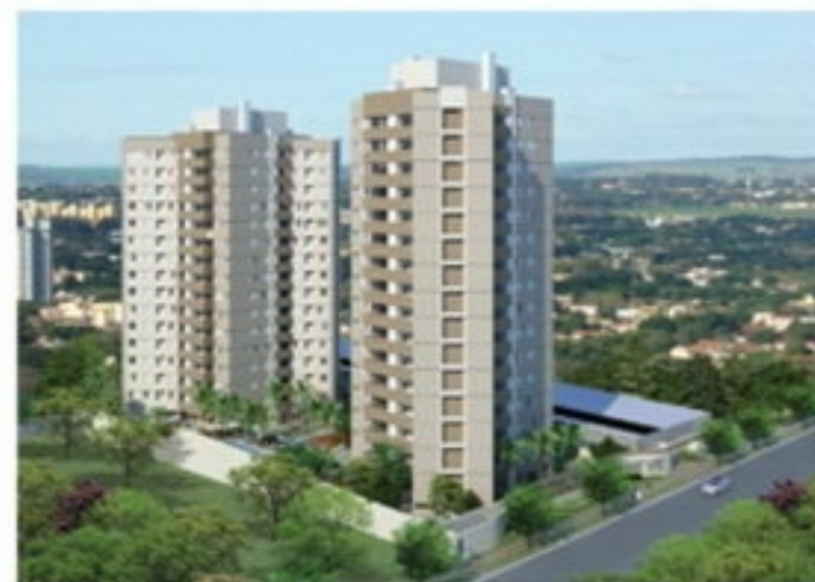
Edifício Bonnevie Halchuk Residencial Club - Maringá -PR
